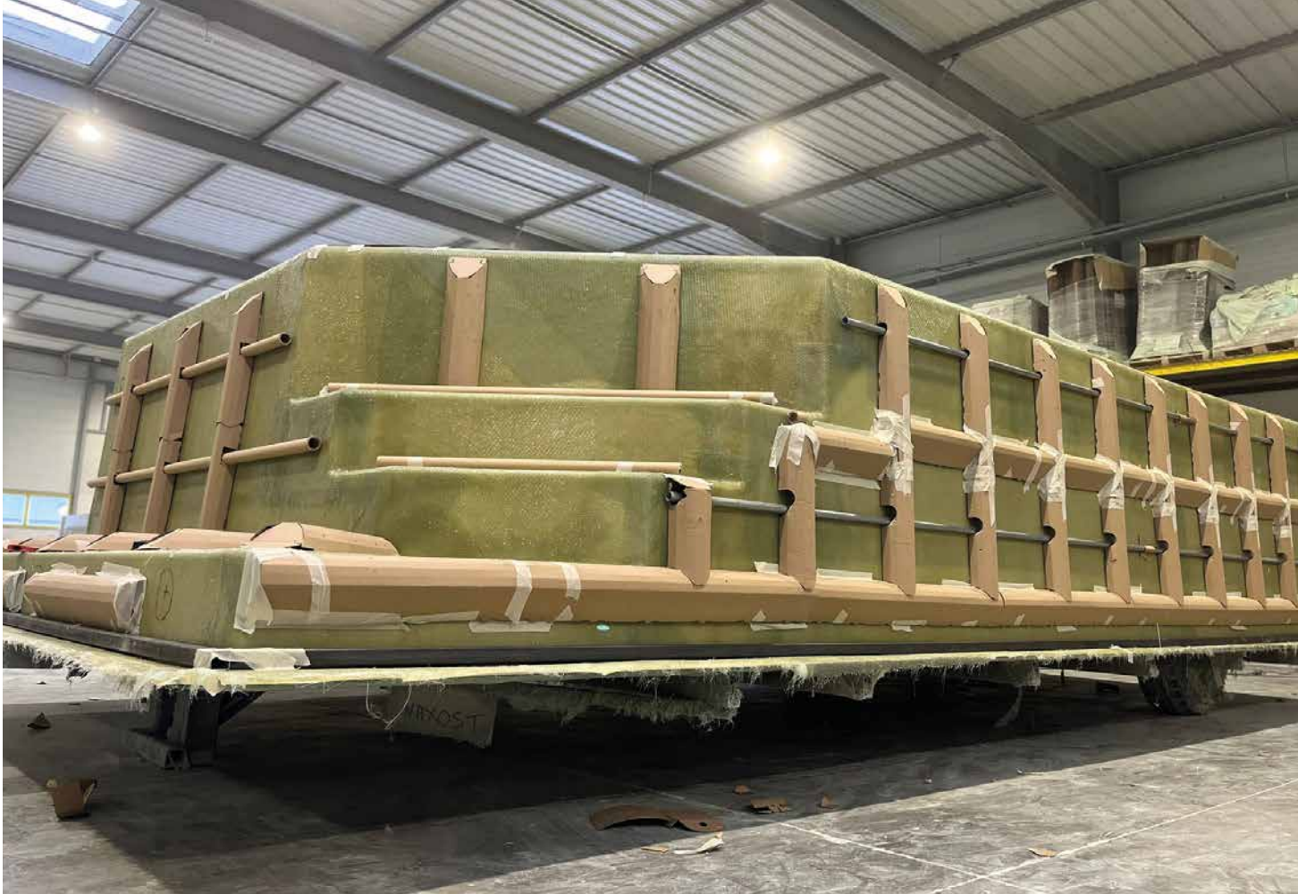
3/ Mise en place des renforts
