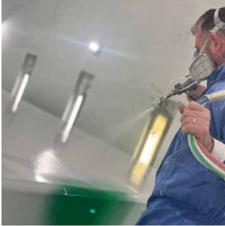
1/ Gelcoatage du moule
