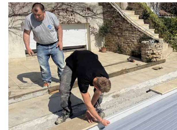
11/ Pose des margelles
