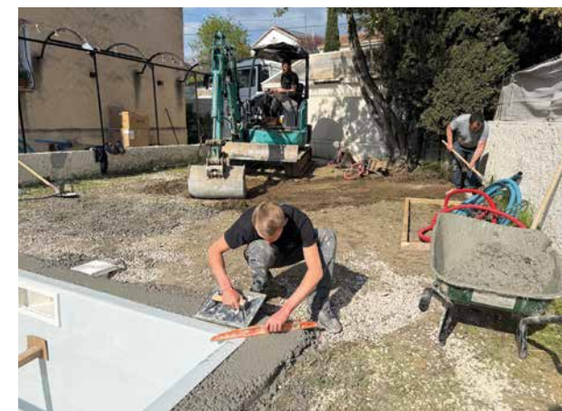
10/ Ceinture béton
