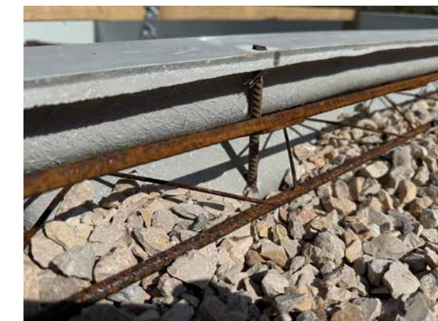
9/ Suite remblaiement - Ferrailage
