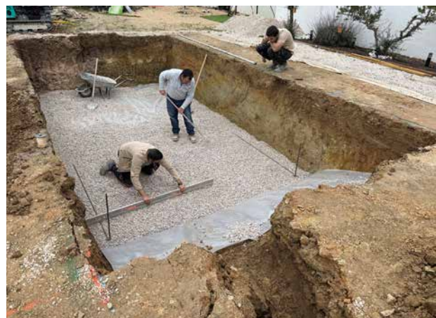
4/ Assise - Tirage radier
