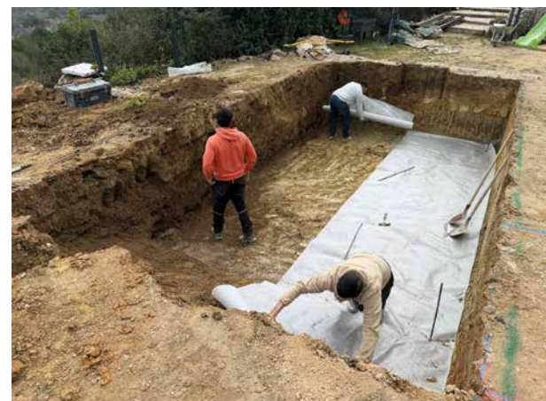
3/ Pose Géotextile
